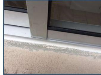
Figura 13 – detalhe silicone nos perfis
