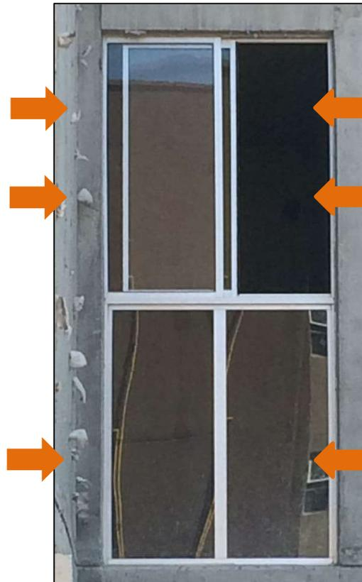
Figura 14 – Instalação do janelão da sala
